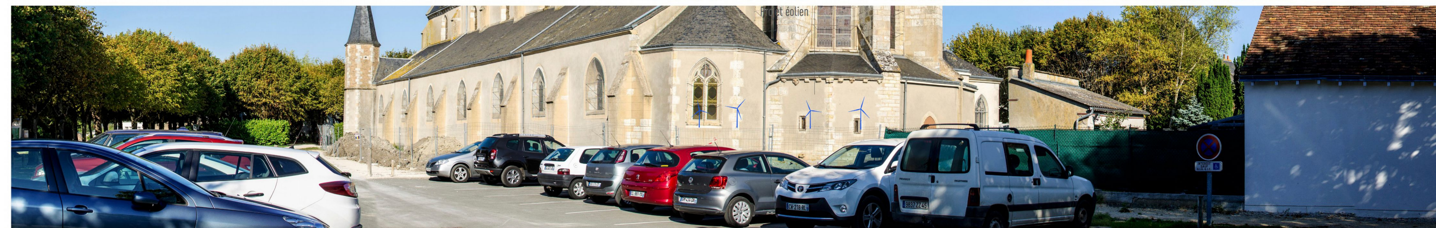
Point de vue n°45: Distance de l'éolienne la plus proche (E1) : 3,8 km. L'église St.Symphorien à Neuville-aux-Bois fait partie du patrimoine classé le plus proche du projet. A ce titre un photomontage est réalisé qui montre qu'il n'y a pas de co-visibilité possible depuis l'église et son aire de mise en scène. Elle se situe au centre-ville entouré d'un tissu urbain dense. Absence d'impact.
