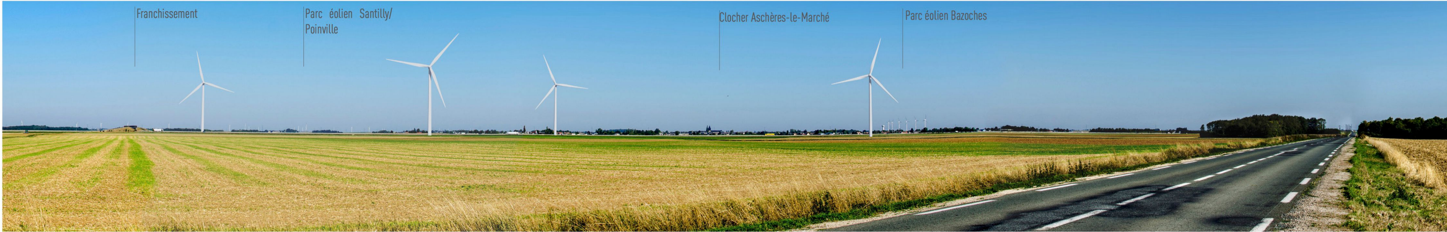
Point de vue n°4: Distance de l'éolienne la plus proche [E2] : 1,2 km. Perception du projet depuis le Sud de l'aire d'étude. En quittant la Forêt d'Orléans, la RD97 (voie romaine) traverse une large plaine agricole. Le parc éolien d'Asnières suit les silhouettes boisées des villages avec une composition géométrique sans effet d'écrasement. On distingue à peine les constructions éloignées. C'est également valable pour le clocher de l'église classée MH. Il est visible, mais il ne se distingue pas des autres éléments de paysage dans le lointain. A l'horizon lointain, on observe différents parcs éoliens, notamment celui de Bazoches. Mais les parcs existants sont suffisamment éloignés pour ne pas fusionner visuellement avec le présent projet ce qui évite un effet de saturation. Le projet ne dévalorise pas le paysage de plaine. Angle de vue 120°.
